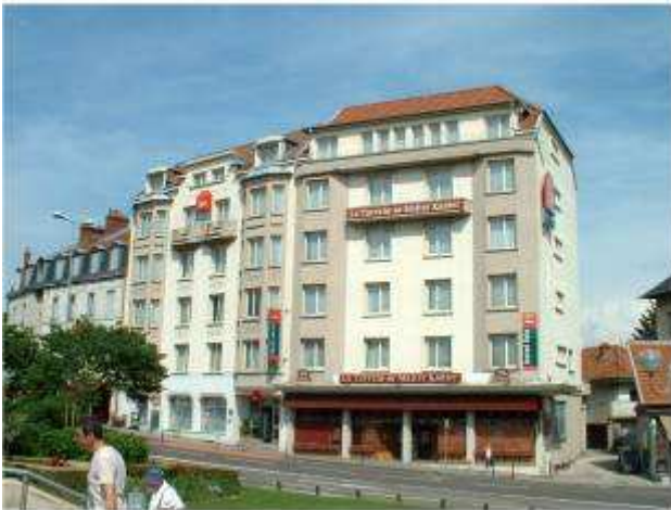
Existant: façade sur l'avenue Foch
